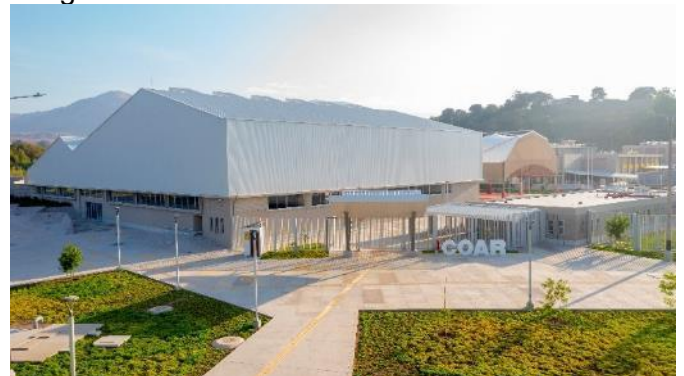
Fachada, COAR Moquegua
